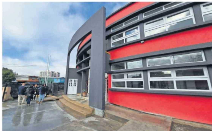
Entre las obras del colegio Rebeca Matte se considera la renovación de la fachada.
