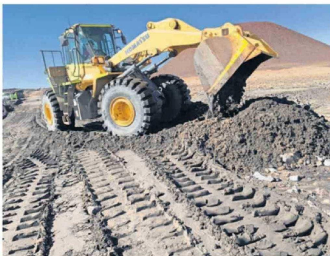
DESPLIEGUE DE MAQUINARIA PESADA EN RUTAS CORDILLERANAS.
