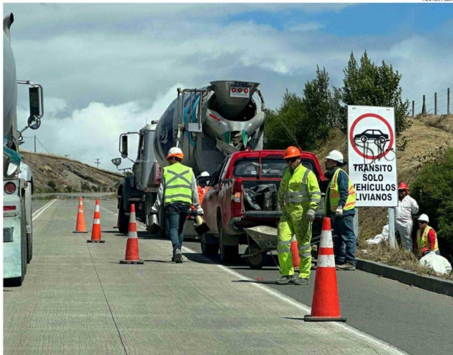
TRABAJOS DURANTE EL VERANO EN LAS CERCANÍAS DEL ACCESO NORTE DEL BYPASS DE CASTRO.
