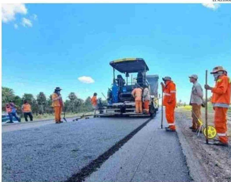
EL ASFALTO EN CONCRETO DE LA DISTANCIA DE 15.5 KILÓMETROS PROYECTA UNA INVERSIÓN APROXIMADA DE 10 MIL MILLONES DE PESOS.
