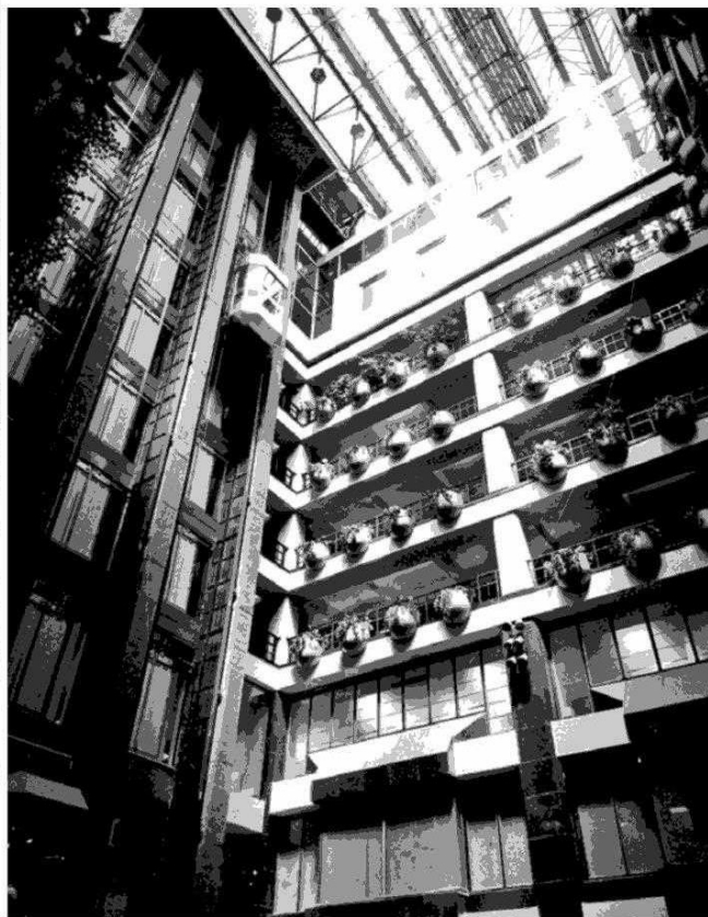
La estructura actual del pasaje Matte data de 1954; es obra de A. Cruz Eyzaguirre.
