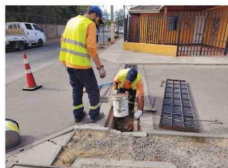
EN LAS POBLACIONES SE DESTAPAN CANALETAS SUBTERRÁNEAS.
