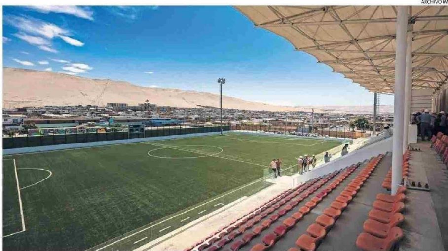
EMPRESA QUE SE HIZO CARGO DE LA OBRA, QUEBRÓ, POR LO QUE, SE TUVIERON QUE CONTRATAR A NUEVOS PROFESIONALES PARA AVALAR PROYECTO.
