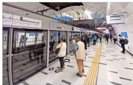
PUERTAS. —Así son las puertas instaladas en las líneas 3 y 6, las que Metro buscará implementar en otras líneas.
