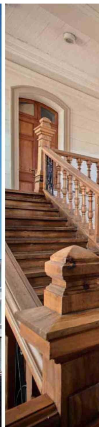
El edificio de Cumming 29 se construyó entre los años 1908 y 1914 por la Dirección de Arquitectura del Ministerio de Obras Públicas de Chile.
