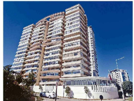
EL “MIRADOR CORACEROS” ES EL EDIFICIO MÁS AFECTADO.
