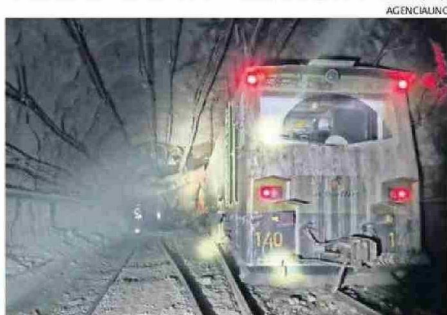
SE DETUVO REMOCIÓN DE ESCOMBROS EN EL PROYECTO ANDESITA.
