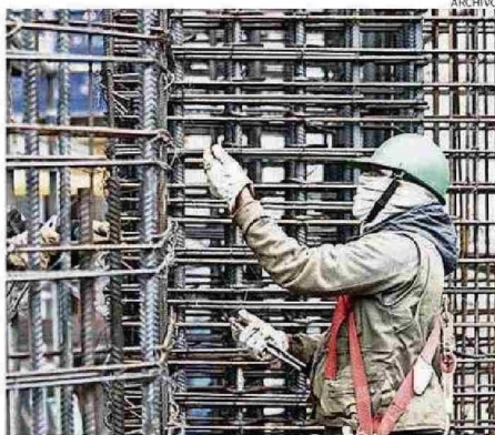
LA CONSTRUCCIÓN EN NUBLE SE CONCENTRA EN VIVIENDAS PÚBLICAS.
