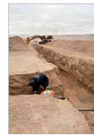
Perú también construye zanjas junto al límite. Uchileños cerca del control Santa Rosa, buscan principalmente evitar que los vehículos evadan las fiscalizaciones. | C 11
