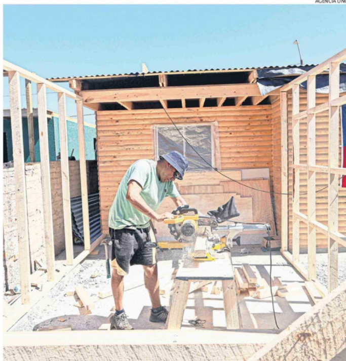
LOS VECINOS ESTÁN CONSTRUYENDO CON SUS RECURSOS Y SUS PROPIAS MANOS SUS VIVIENDAS.
