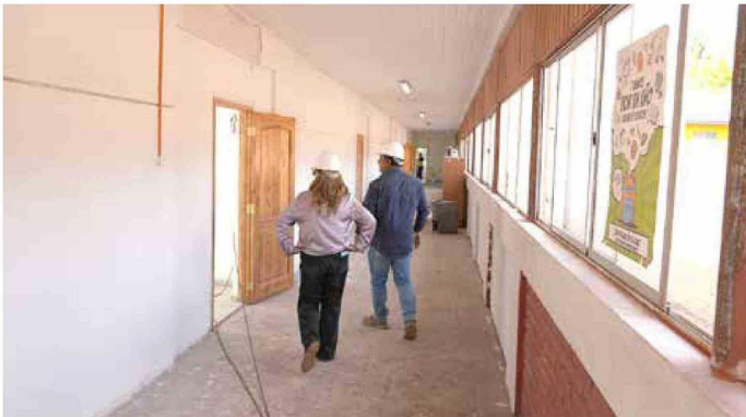
Las obras en la Escuela Santa Aurora de Carrizal superan los $230 millones con término a fines de este mes y en la Escuela de Loanco la inversión es cercana a los $290 millones.
