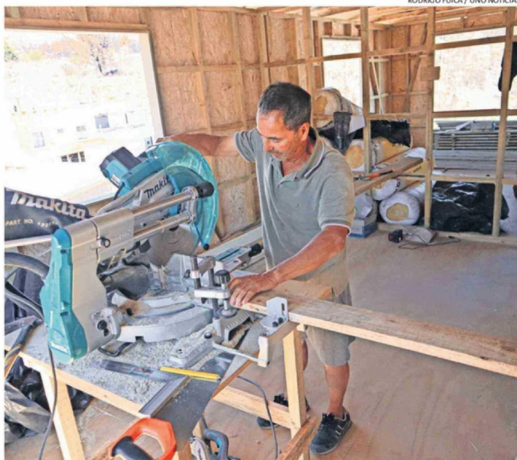
EL TOMECINO HERIBERTO MELLA TRABAJANDO EN LA RECONSTRUCCIÓN DE SU VIVIENDA.
