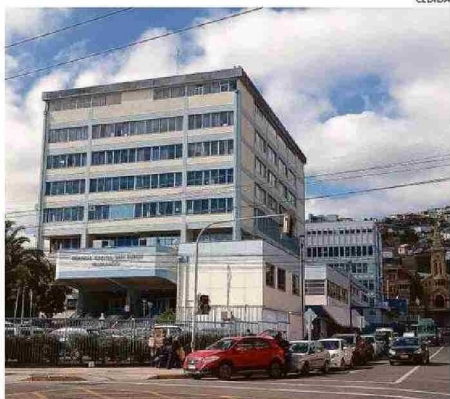
EL RECINTO REQUIERE URGENTEMENTE DE UNA AMPLIACIÓN.
