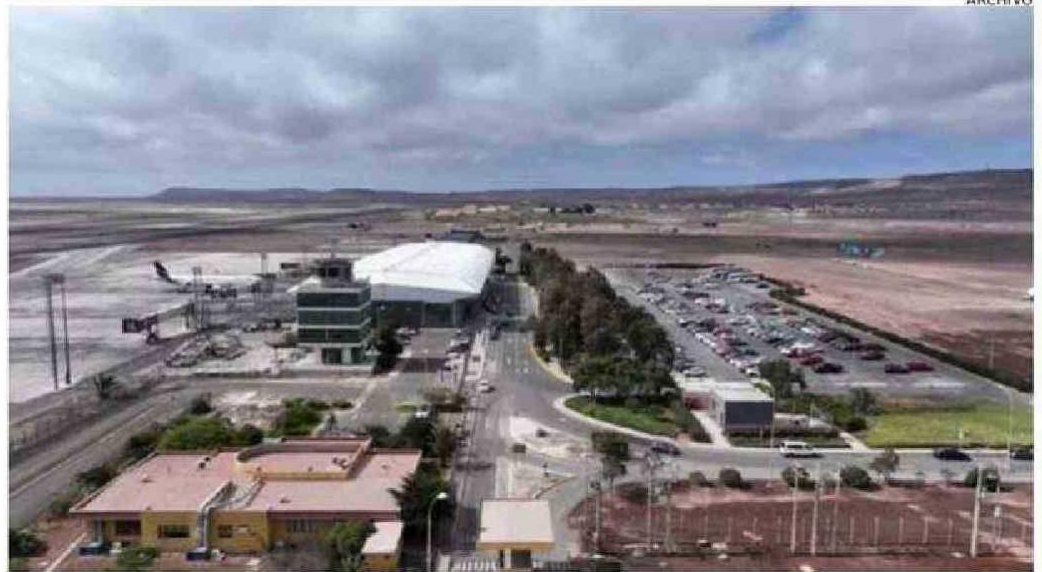
Las obras de mejoramiento en la pista de aterrizaje tendrán una duración de tres semanas.
