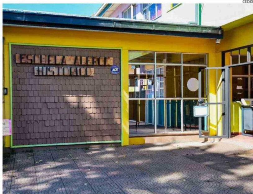
LOS TRABAJOS BUSCAN RESOLVER FALLAS ESTRUCTURALES Y MEJORAR LA AISLACIÓN TÉRMICA.
