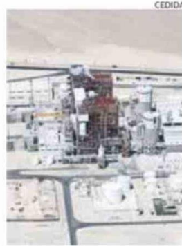
LA TERMOELÉCTRICA DE AES CHILE.
