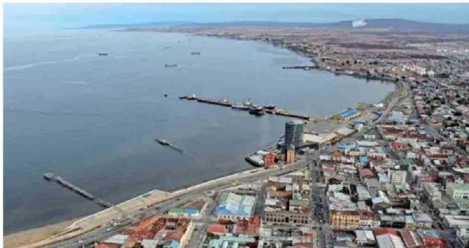
El estrecho de Magallanes podría transformarse en una plataforma de transbordo estratégica si se desarrolla la infraestructura adecuada.
