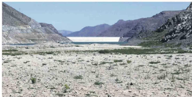
Autoridades de la región se han apresurado en hacer gestiones a nivel central que permitan contar con recursos para actuar preventivamente en la captación de nuevas fuentes de agua.
