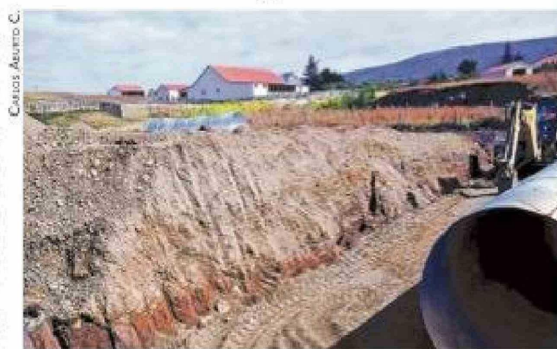
Con avances de un 85 y 35 por ciento, respectivamente en cada tramo, continúan la pavimentación de la Ruta Y-71 (Porvenir-Onaisín) en Tierra del Fuego.
