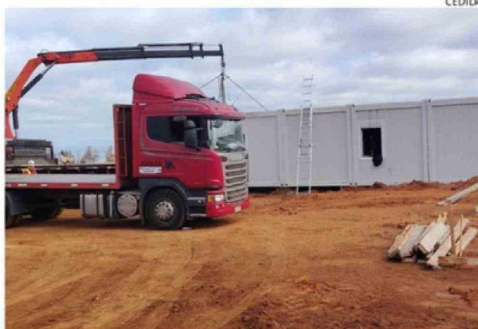
INSTALACIÓN DE MÓDULOS PARA LA ESCUELA PUNTA DE PARRA.
