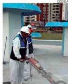
TRABAJOS EN PILETA SECTOR SUR.
