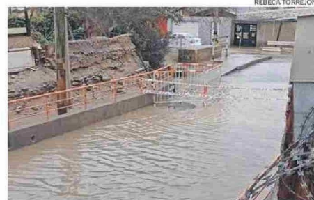
EL PUENTE BRASIL TERMINÓ DESBORDADO DE AGUA.
