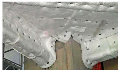
Protección F120 losa colaborante en edificio de Entel.
