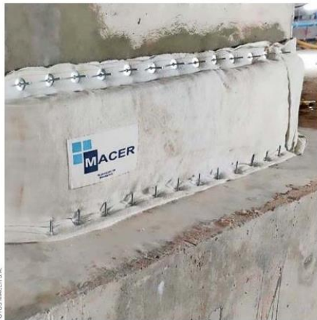
Protección F180 aislador sísmico en Hospital de Curicó.
