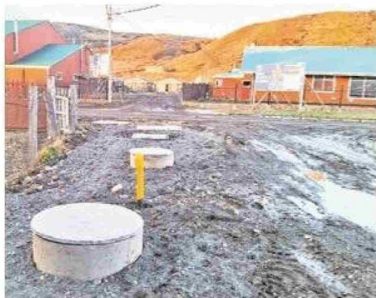
Las nuevas fosas sépticas en Villa Cameron.
