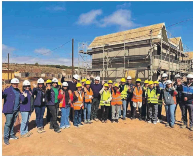
Las familias del comité Santa Elena recorrieron las obras del proyecto habitacional en La Chimba, que actualmente registra un 30% de avance general.
