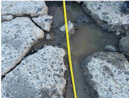
Baches de hasta 12 centímetros de profundidad.
