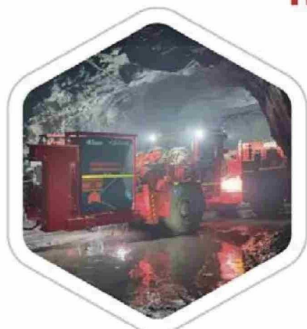
Descarbonización de la voladura
