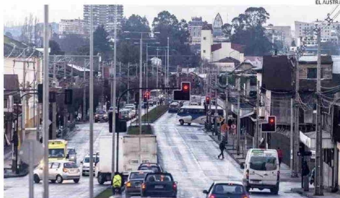
LAS OBRAS SE TERMINARON EN 2021, 16 MESES DESPUÉS DEL PLAZO ESTIPULADO EN EL CONTRATO.
