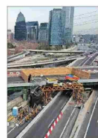
Reemplazo de viga dejará al puente Le Saldares (Viñadura) totalmente cerrado hasta el 23 de agosto. | C 7
