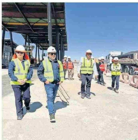
AUTORIDADES LOCALES INSPECCIONARON LA OBRA.
