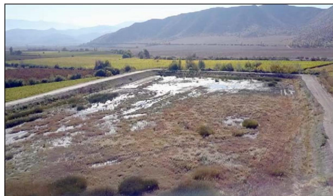
CUENTA REGRESIVA.- Este es el gran tranque con capacidad de 49.000 litros de agua, el que pronto estará funcionando para el agro de Santa María.
