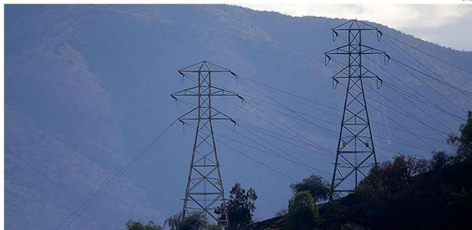
EL PROYECTO CONSISTE EN LA CONSTRUCCIÓN Y OPERACIÓN DE TRES TRAMOS DE LÍNEA DE TRANSPORTE DE ENERGÍA ELÉCTRICA.
