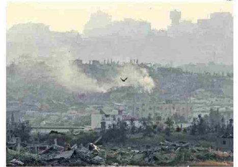
BOMBARDEO DEJÓ REDUCIDO A ESCOMBROS BARRIO RESIDENCIAL EN GAZA.
