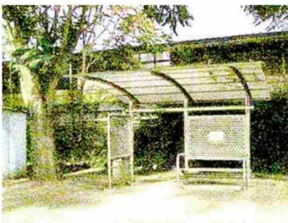
El paradero de buses de Escuela Cataluña, en calle Merino Jarpa, sigue sin iluminación.
