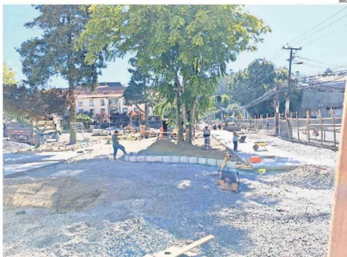
ESTE ES EL ACTUAL ESTADO DE LOS TRABAJOS QUE SE DESARROLLAN EN LA PLAZA PERÚ DE CONCEPCIÓN.
