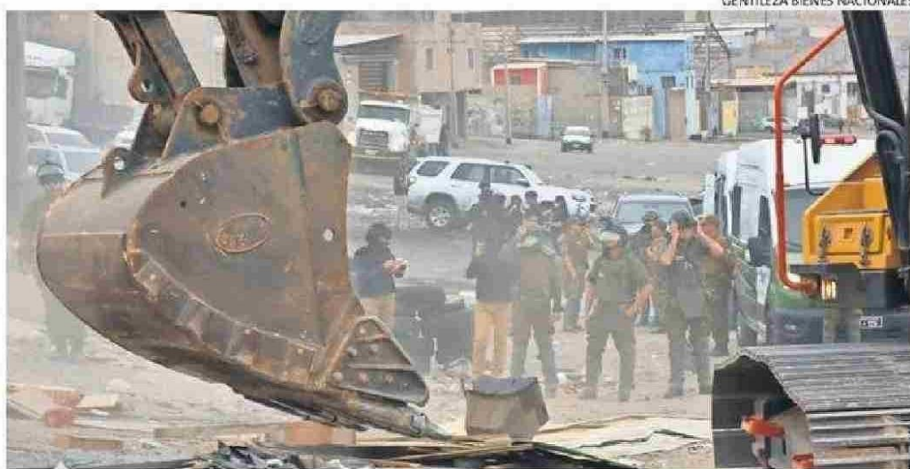
LAS INSTITUCIONES SIGUEN TRABAJANDO PARA MEJORAR LA SEGURIDAD Y EL USO DEL ESPACIO.
