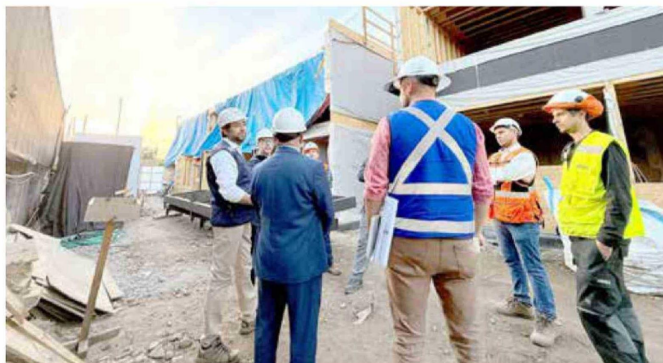
El seremi de Vivienda y Urbanismo, Patricio Ponce, visitó las obras de construcción del Condominio Cipreses del Maule.
