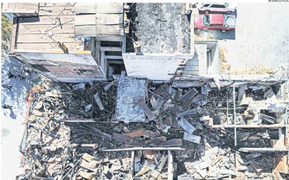
LOCATARIOS ADVIRTIERON QUE PERSONAS HAN INGRESADO ENTRE LOS ESCOMBROS DE LA CASONA DESTRUIDA EN CALLE SAN MARTÍN. RODRIGO FUICA
