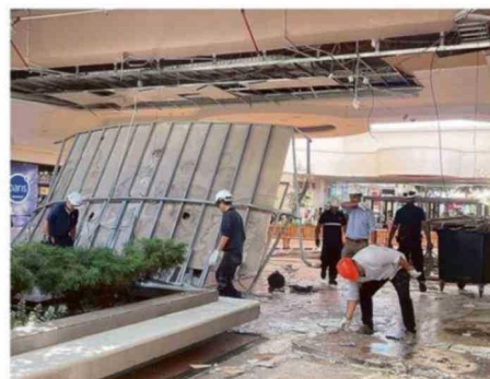
RETIRO DE ESCOMBROS OCASIONADOS POR EL DESPRENDIMIENTO.
