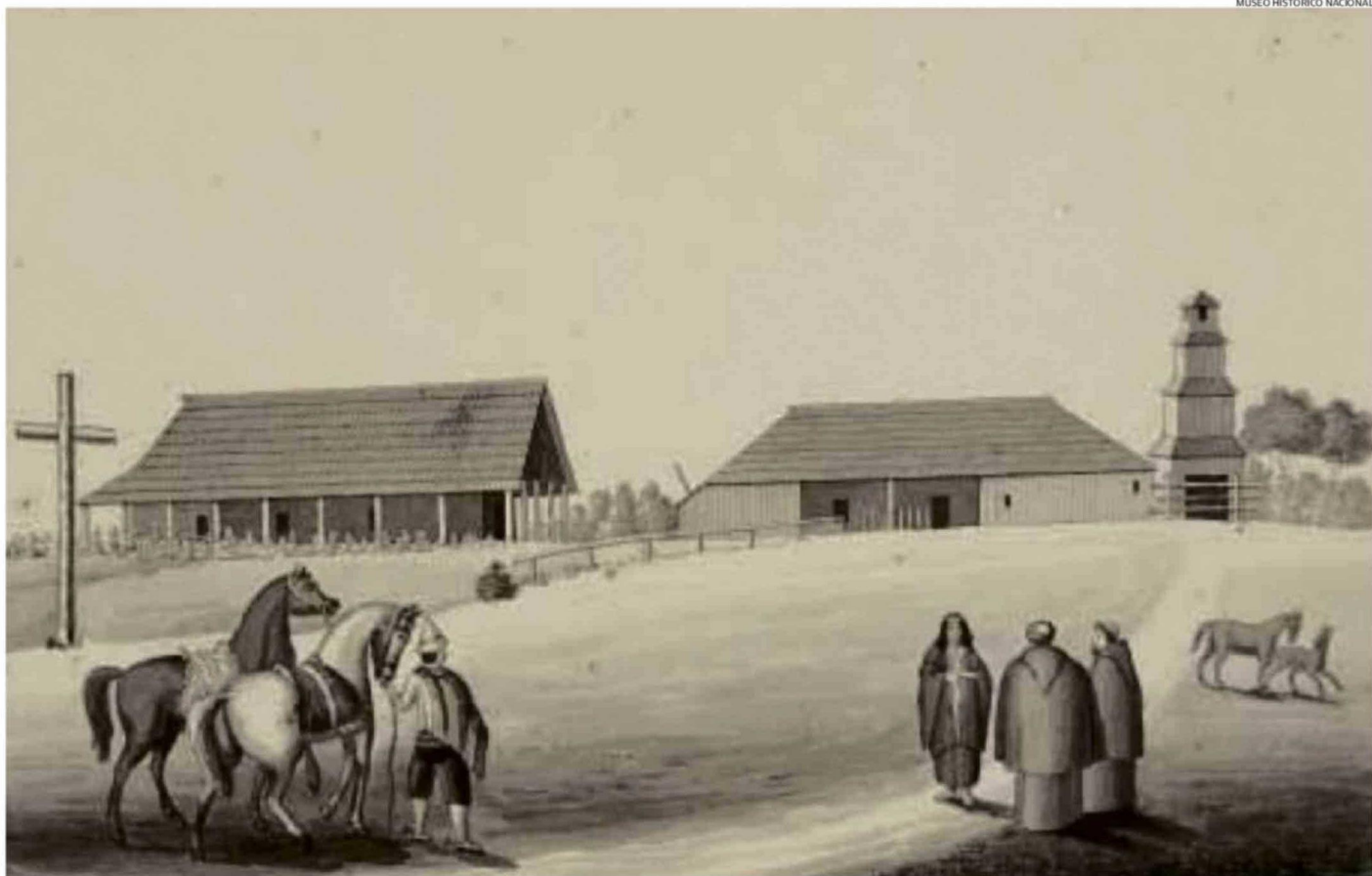
GRABADO DE RODULFO PHILIPPI DE LA MISIÓN DE DAGLLIPULLI EN 1852. LAS CONSTRUCCIONES ERAN MADERA RÚSTICA, TANTO LA CAPILLA COMO LA CASA DE LOS MISIONEROS Y DEMÁS DEPENDENCIAS.
