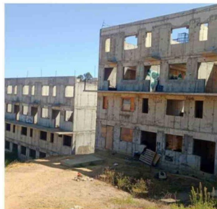
ESTADO ACTUAL DE CÓMO QUEDARON LAS OBRAS.
