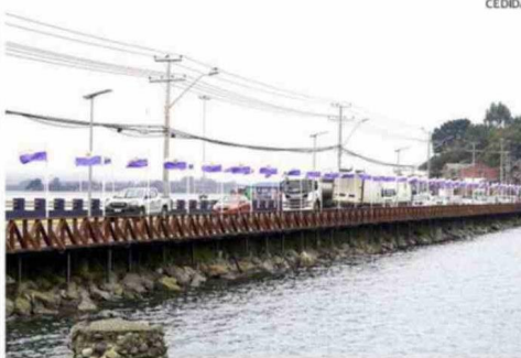
DESTACARON QUE EL PIEDRAPLÉN FUE CONSTRUIDO A PULSO.
