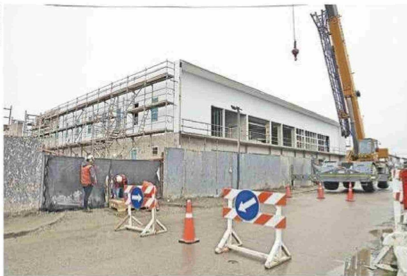
La empresa Salva viene ejecutando la obra de construcción del nuevo consultorio 18 de Septiembre, en la esquina de Gaspar Marín y Mateo de Toro y Zambrano.
