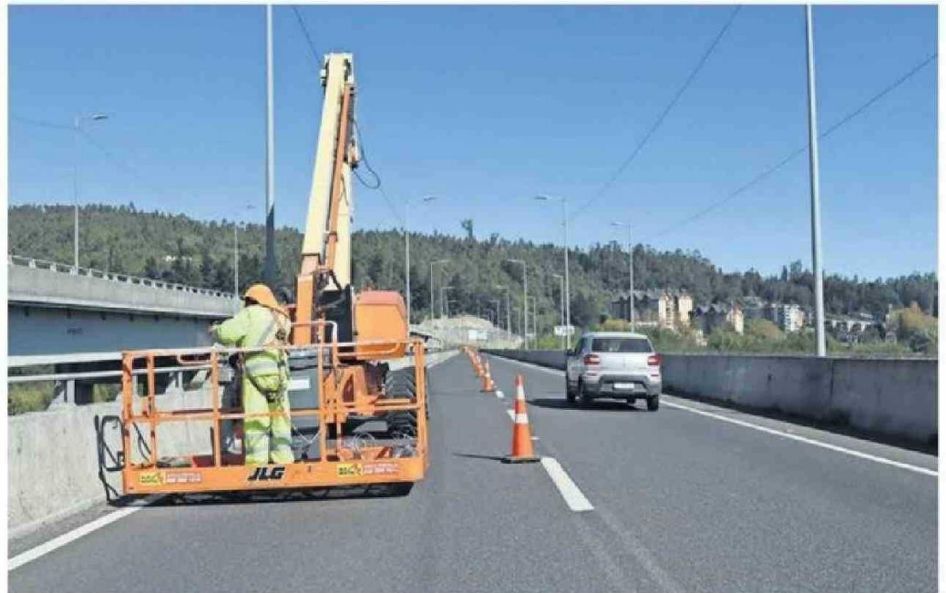
La Dirección de Vialidad ejecutando la instalación de los sensores.
