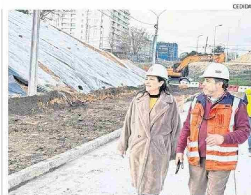
AUTORIDADES INSPECCIONAN AVANCE DE LAS OBRAS.
