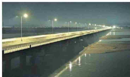
Son más de 100 las luminarias del viaducto.
